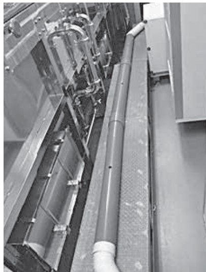
第2図 多孔ダクトによるガス拡散
