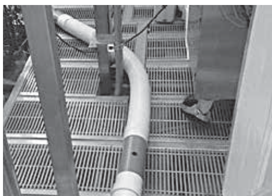
第6図 伸縮ダクトの組み合わせによるガス拡散経路
