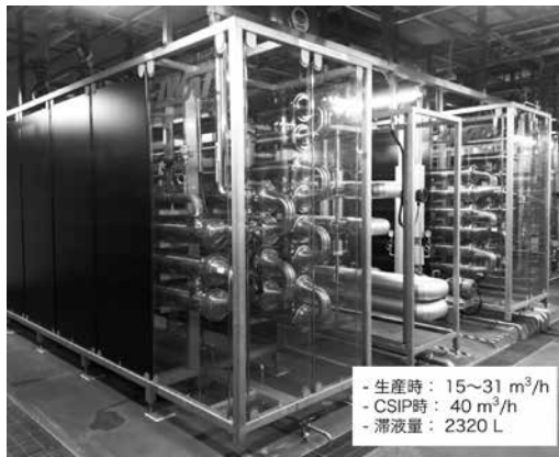
第14図 実機検証：S&T式熱交換器
